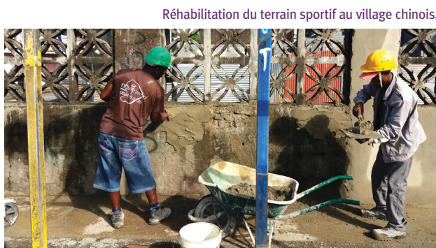
Réhabilitation du terrain sportif au village chinois.
