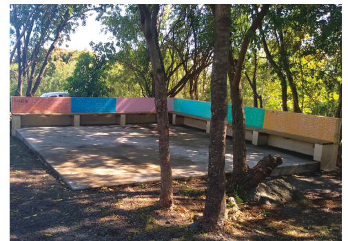
Espace santé : plateforme et bancs en béton.
