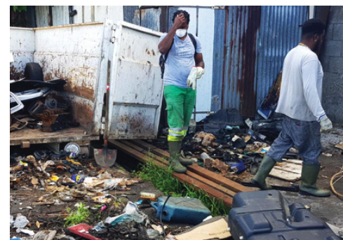
Désencombrement des délaissés urbains.
