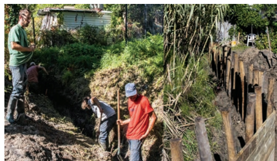
Travaux de soutien des berges d'un ruisseau.
