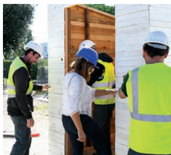
Construction de toilettes sèches.
